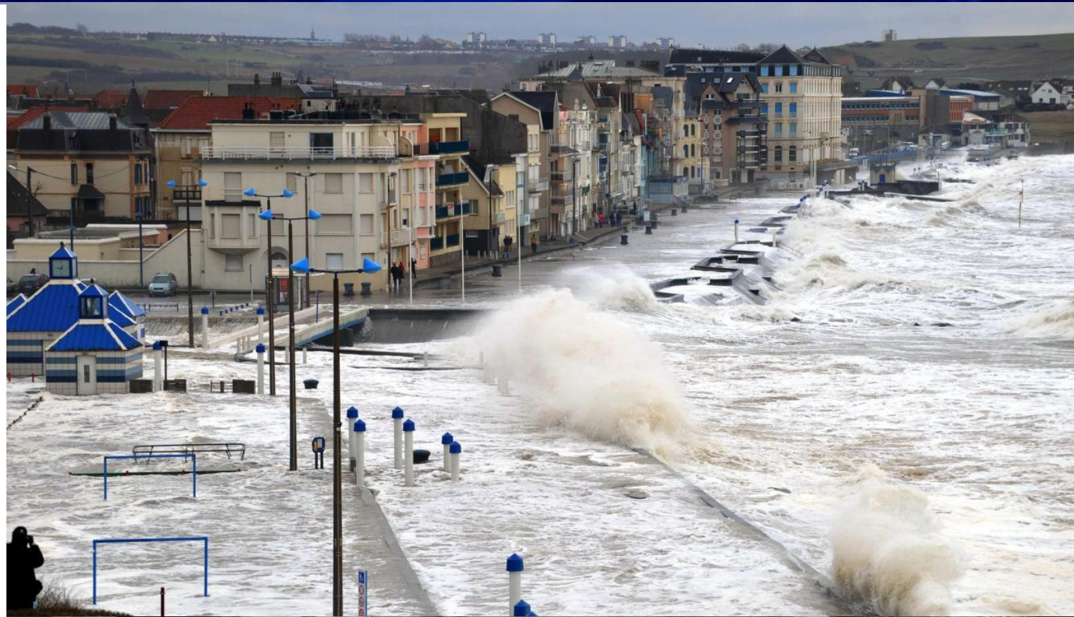
Photos de la digue de Wimereux (Hauts de France) pendant une tempête (©LaVoixDuNord) puis le 4 Janvier 2018 suite à la tempête Eléonor (©LCI/TF1)
